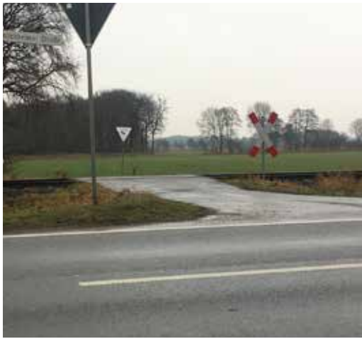
Bahnübergänge wie dieser am Lamberg (Gemeinde Ringe) sollen gesichert oder aufgehoben werden.
